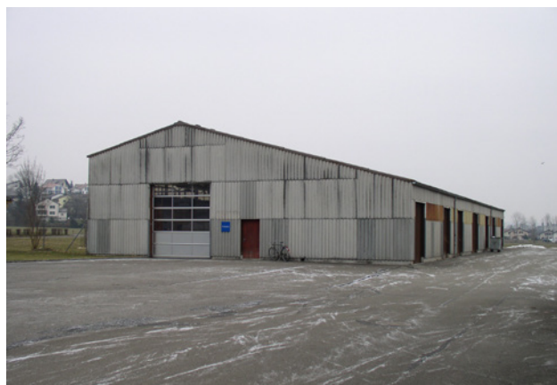
1 Mit Wellplatten aus Faserzement verkleidete Industriehalle
